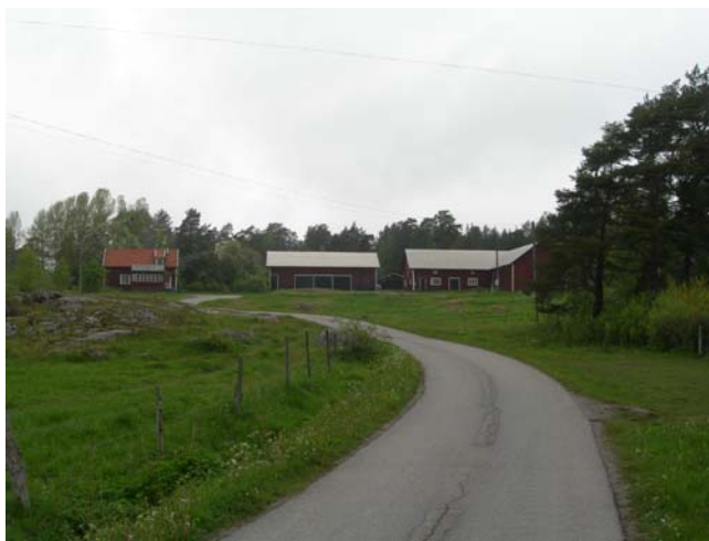
Brannebols gård med boningshus och ekonomibygnader, vy från öst.
